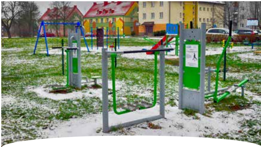
Budowa placu zabaw na osiedlu Czapskiego. Zakończenie inwestycji: 26.07.2017r. Całkowity koszt inwestycji: 29 929,99 zł
