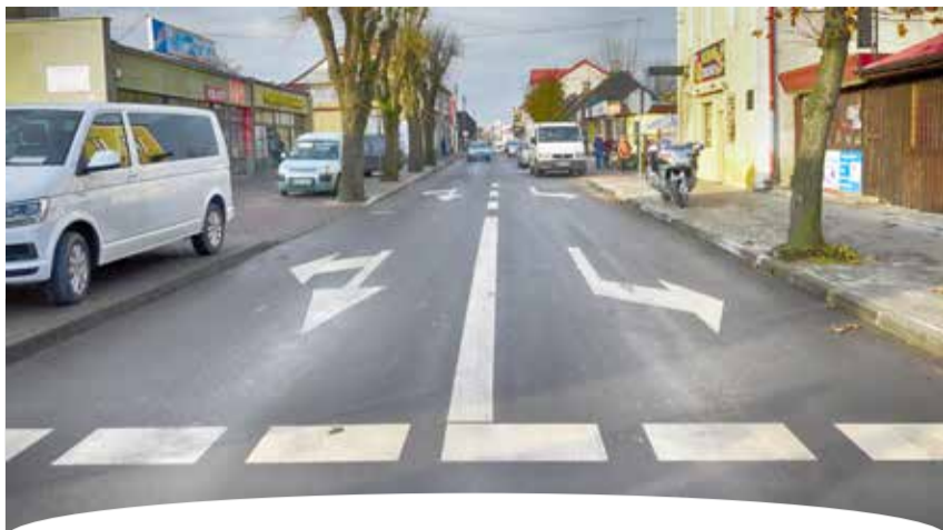
Przebudowa i remont drogi miejskiej ul. Floriańskiej wraz ze zjazdami i skrzyżowaniami z ul. Stodólną, ul. Kujawy i ul. Solidarności w Gostyninie. Termin realizacji: 29.03.2017r. - 24.05.2017r. Koszt inwestycji: 274.370,84 zł brutto
