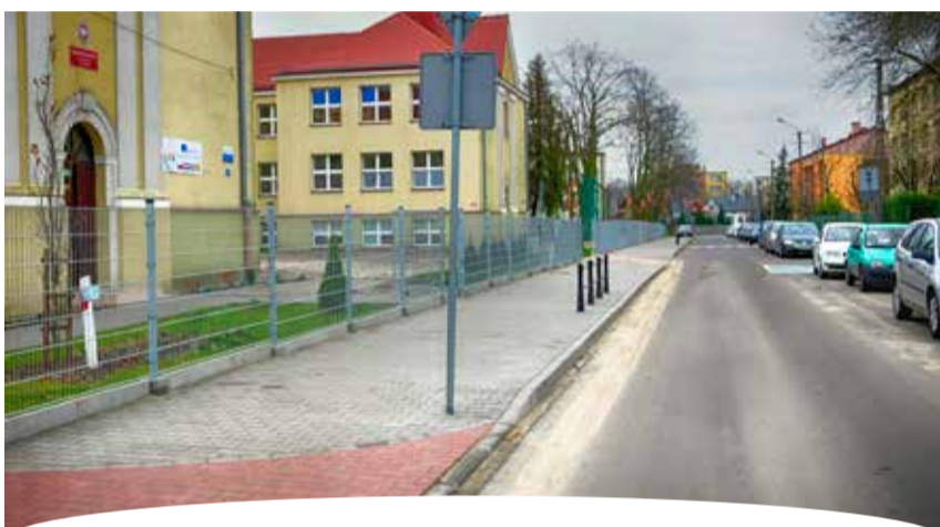
Modernizacja drogi gminnej ul. Ozdowskiego w Gostyninie wraz z modernizacją ogrodzenia przy Szkole Podstawowej nr 1 im. Armii Krajowej. Termin realizacji: 13.07.2017r. - 22.09.2017r. Koszt inwestycji: 307.034,46 zł brutto
