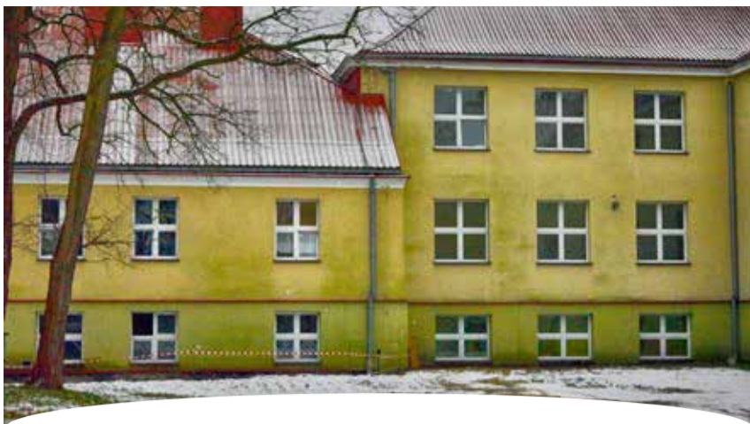
Budowa kanalizacji sanitarnej przy Szkole Podstawowej Nr 1 w Gostyninie. Termin zakończenia robót: 07.11.2017r. Koszt inwestycji: 84 674,85 zł
