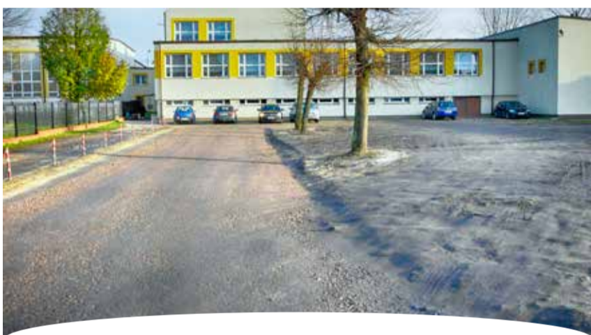
Wykonanie instalacji drenażu na terenie Szkoły Podstawowej Nr 3. Termin zakończenia robót budowlanych 20.11.2017r. Całkowity koszt inwestycji: 22 187,39 zł
