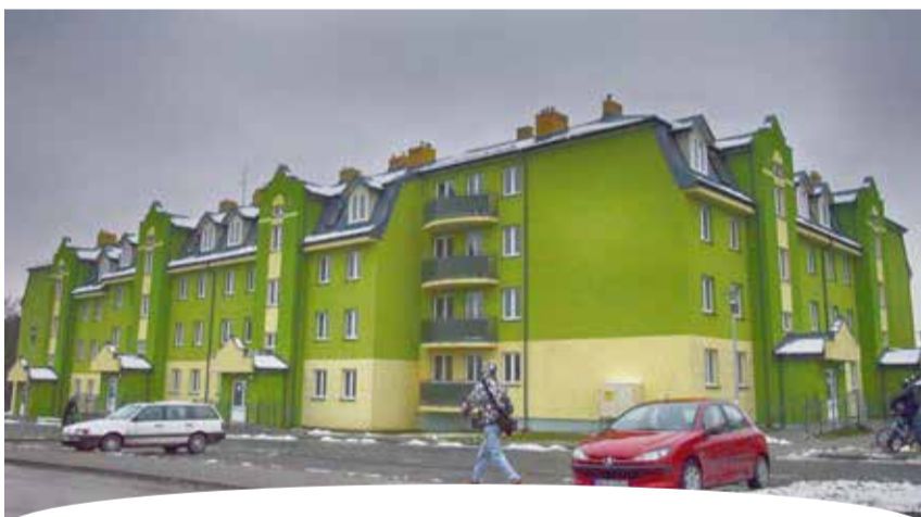
Budowa budynku wielorodzinnego z lokalami socjalnymi Przy ul. Targowej W ramach inwestycji powstało 60 lokali. Pozwolenie na użytkowanie uzyskano 25.10.2017r. Całkowity koszt inwestycji 6 203 296,19 zł
